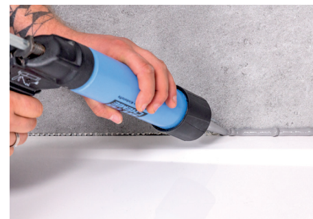
Naar de wand afdichten met siliconen
