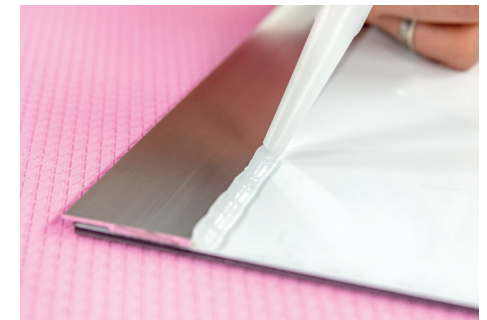
Siliconenvoeg aan de profiel flank trekken
