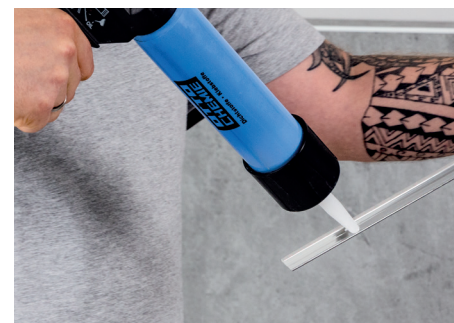
Profielvlakken van siliconen voorzien
