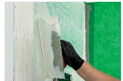
Lijm over het hele oppervlak verdelen
