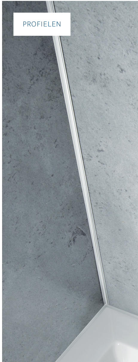
Voorbeeld 1 Inbouw op een rechte wand, met afgerond en recht afsluitingsprofiel
