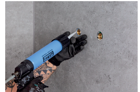
Doorvoeringen voorzien van siliconen
