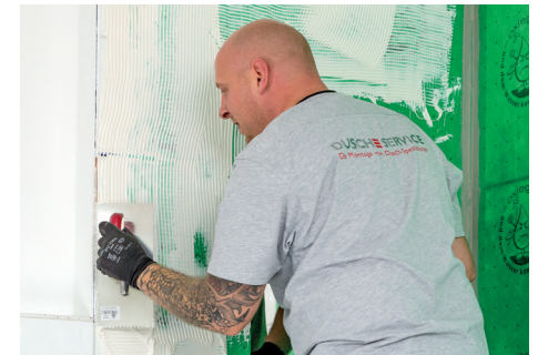
Aanbrengen van de lijm
