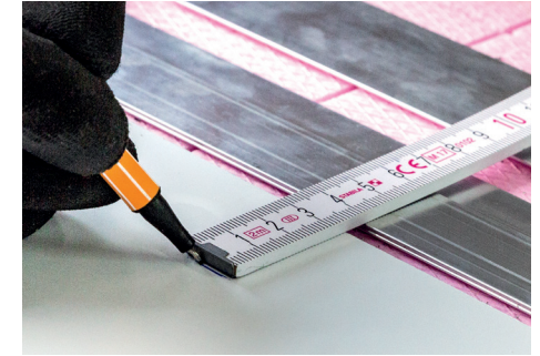
35 mm markering aanbrengen
